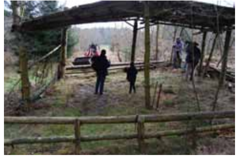
Reparaturen am Schafstall
